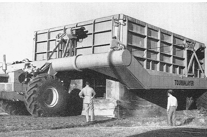
Подковообразная машина перевозит бетонный остов дома с места отливки на подготовленный для него фундамент. Та же машина может перемещать и уже существующие дома, весом до 135 тонн.
