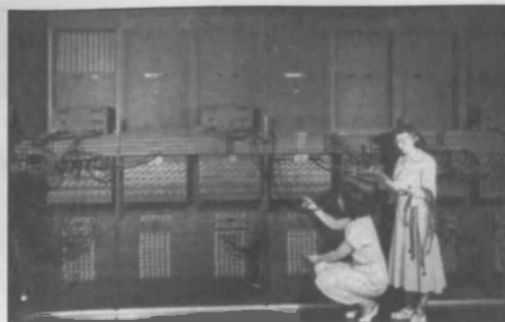
Рис. 23.28. ENIAC, первый электронный компьютер (J. P. Eckert, J. W. Mauchly, 1944/5). На фотографиях видна всего лишь небольшая часть из 18 тысяч вакуумных ламп
