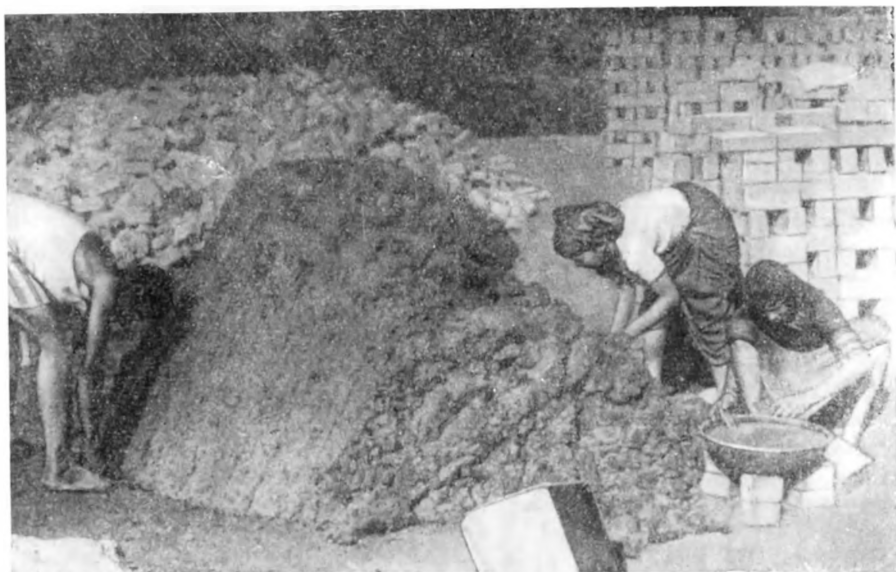
Изготовление сырцовых кирпичей
