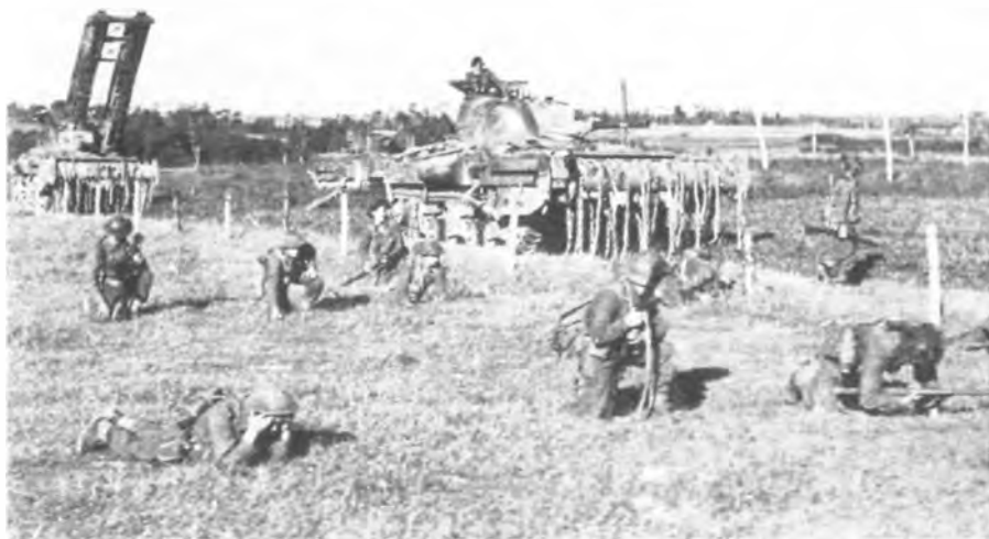
Новейшие машины войны, обеспечивавшие наступление пехоты: справа — танк с минным «тралом», слева — самоходный мост для преодоления проволочных заграждений и ручьев
