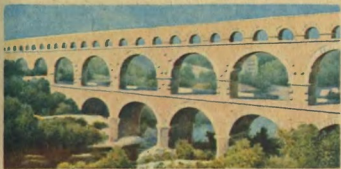
Рис. 281. Римский арочный мост в Гадлии (современной Франции). По мосту проходил водопровод. Высота моста над уровнем реки почти 50 метров.
