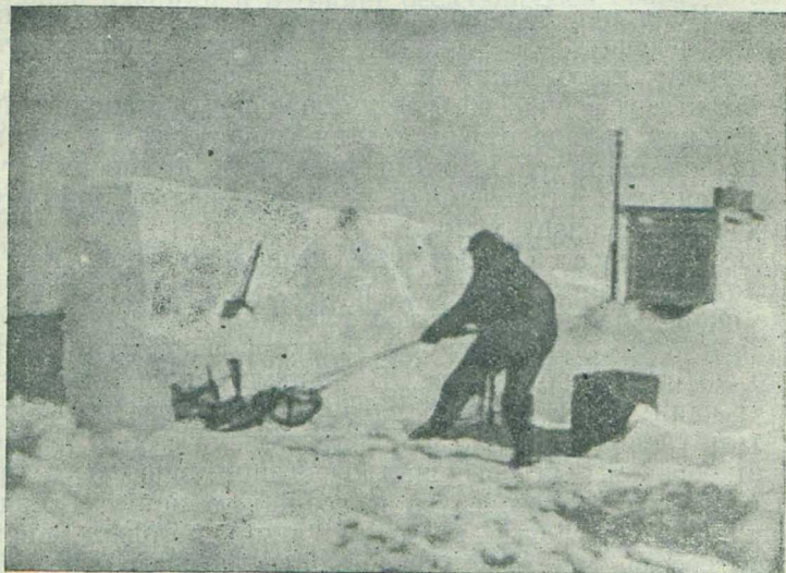
Станция „Айсмитте“. Земляные работы для устройства „подземной“ камеры для барометра и наполнения шаров-пилотов.
