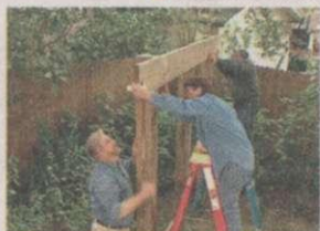
■ Ставим поперечные балки
