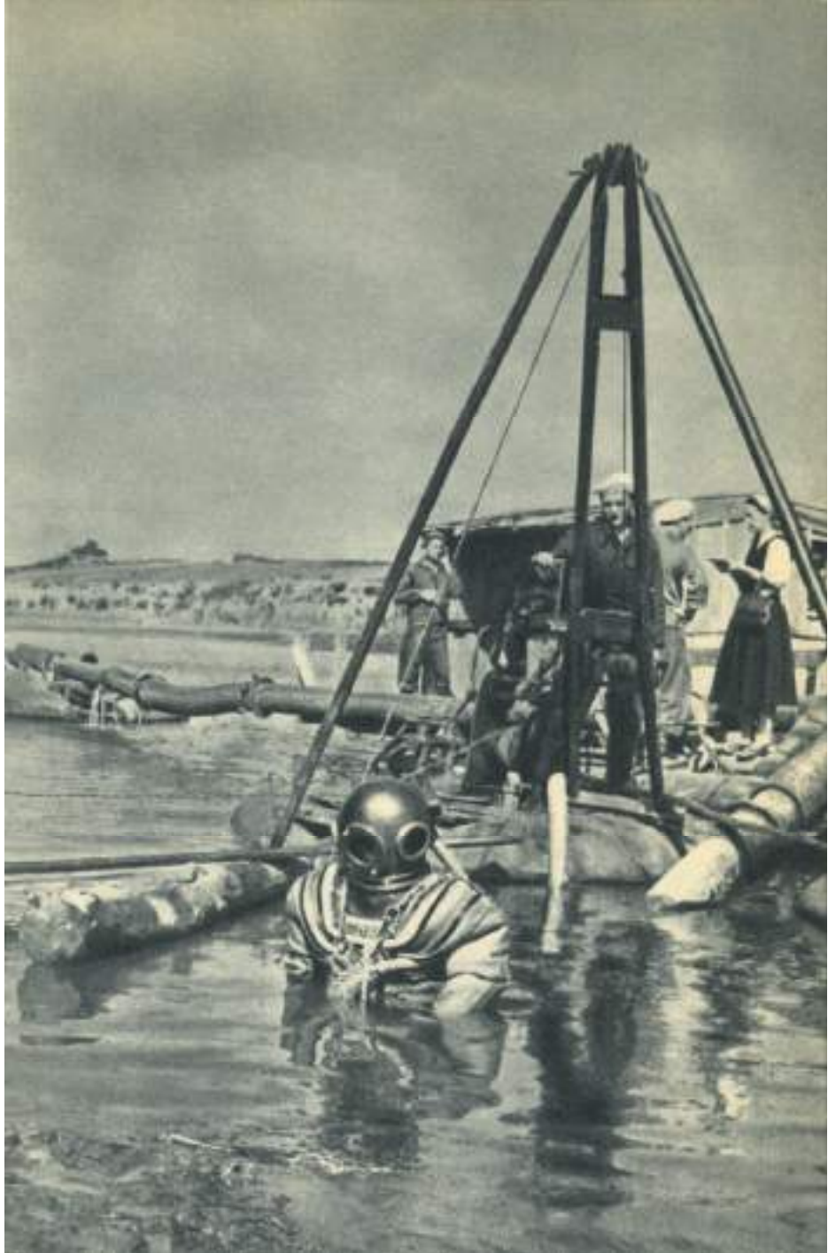
Трубы нефтепровода ложатся под рекою Омь.
