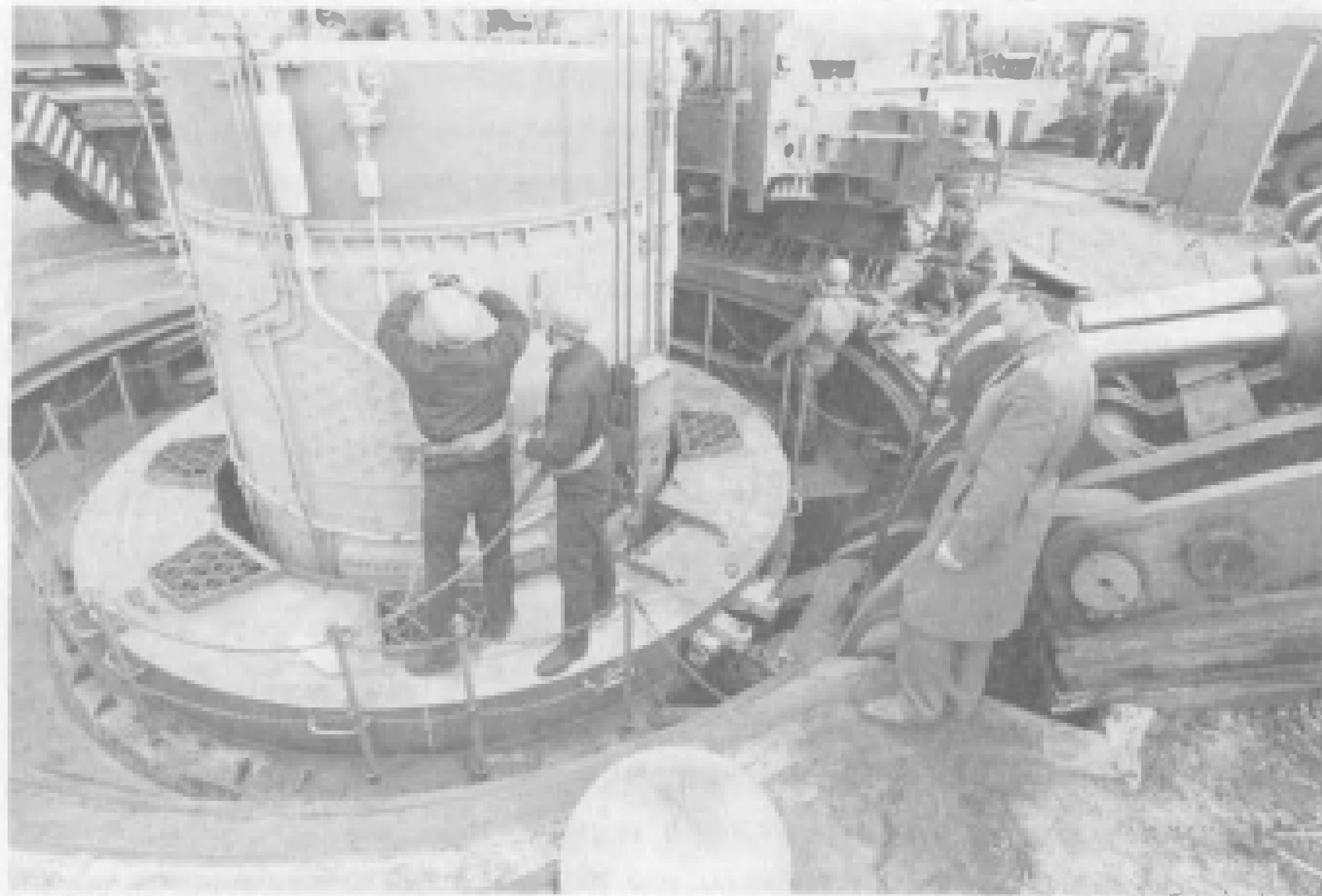
Фото В. Милосердова. Работа боевого расчета по извлечению ракеты SS-19 из ШПУ
