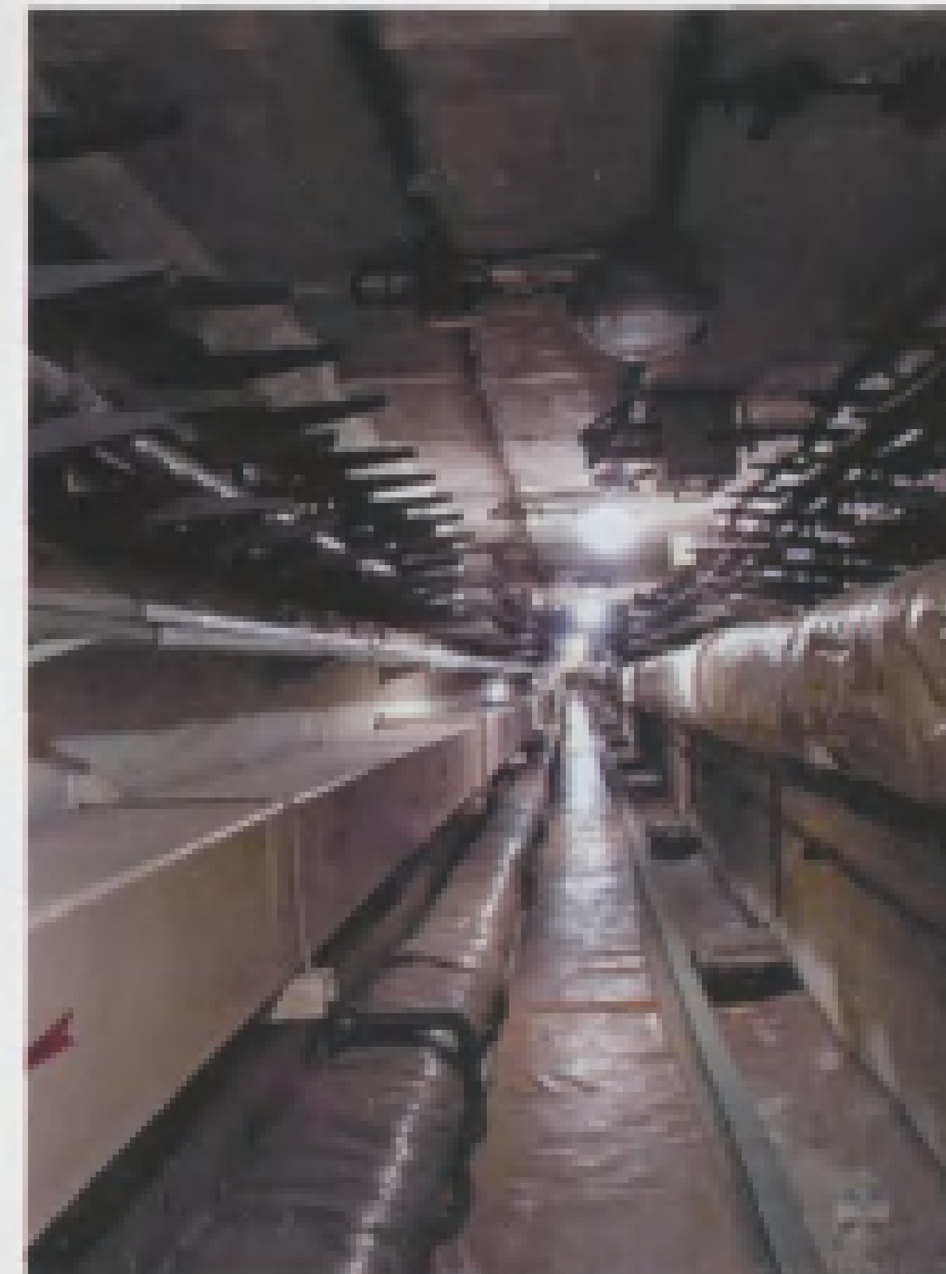
Підземна потерна і герметичні захисні двері входу в УКП ракетного полку «ОС». ДП1, ДП2 відчинені
