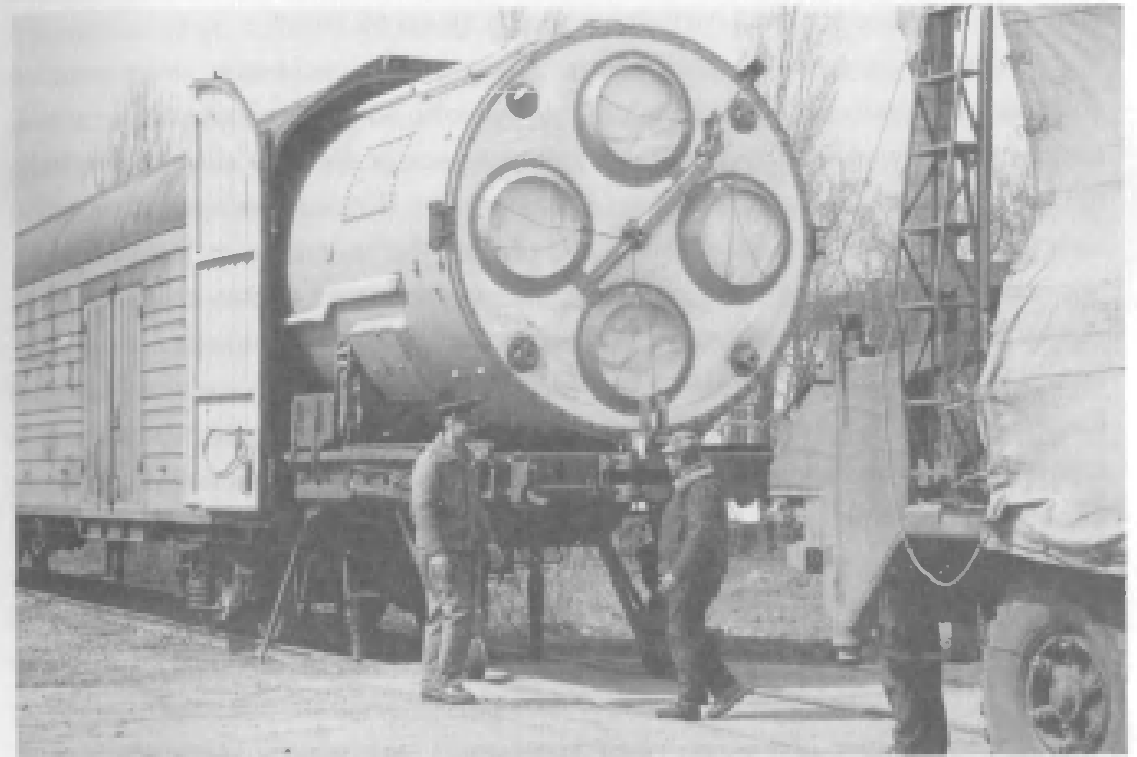
Фото В. Милосердова. Перегрузка ракеты РС-18 с ТПК в железнодорожный вагон
