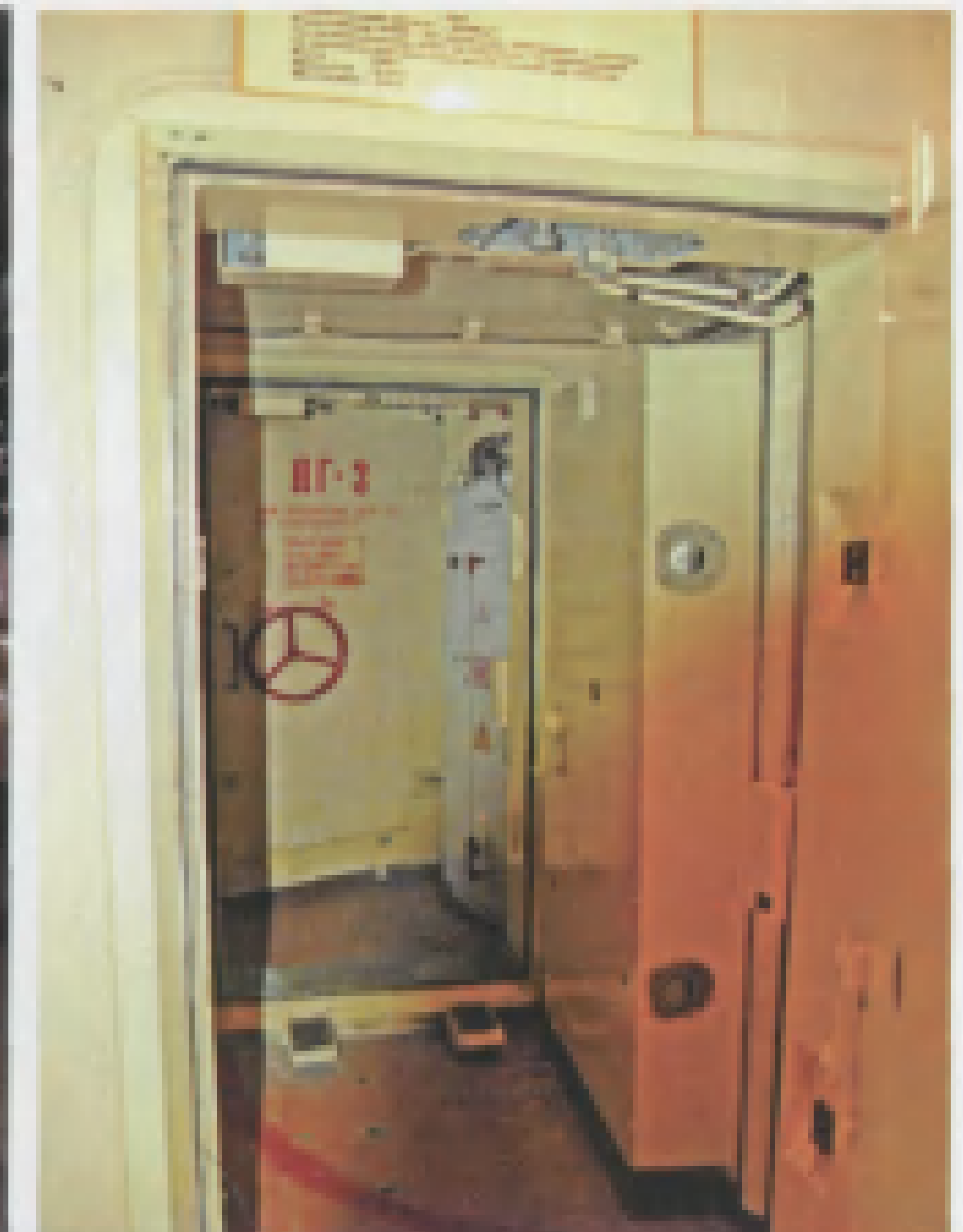
Підземна потерна і герметичні захисні двері входу в УКП ракетного полку «ОС». ДП1, ДП2 відчинені
