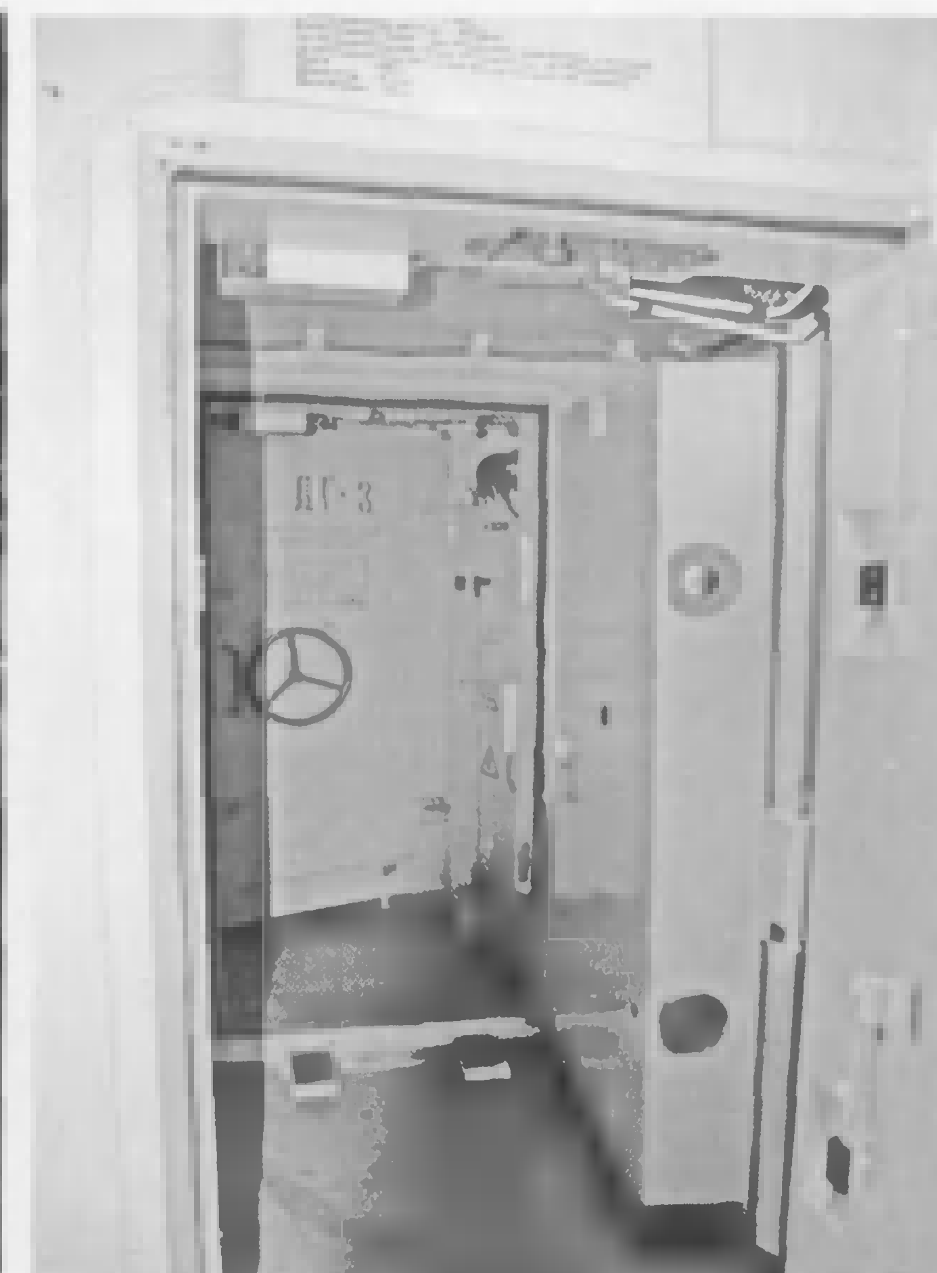
Підземна потерна і герметичні захисні двері входу в УКП ракетного полку «ОС». ДГ1, ДГ2 відчинені
