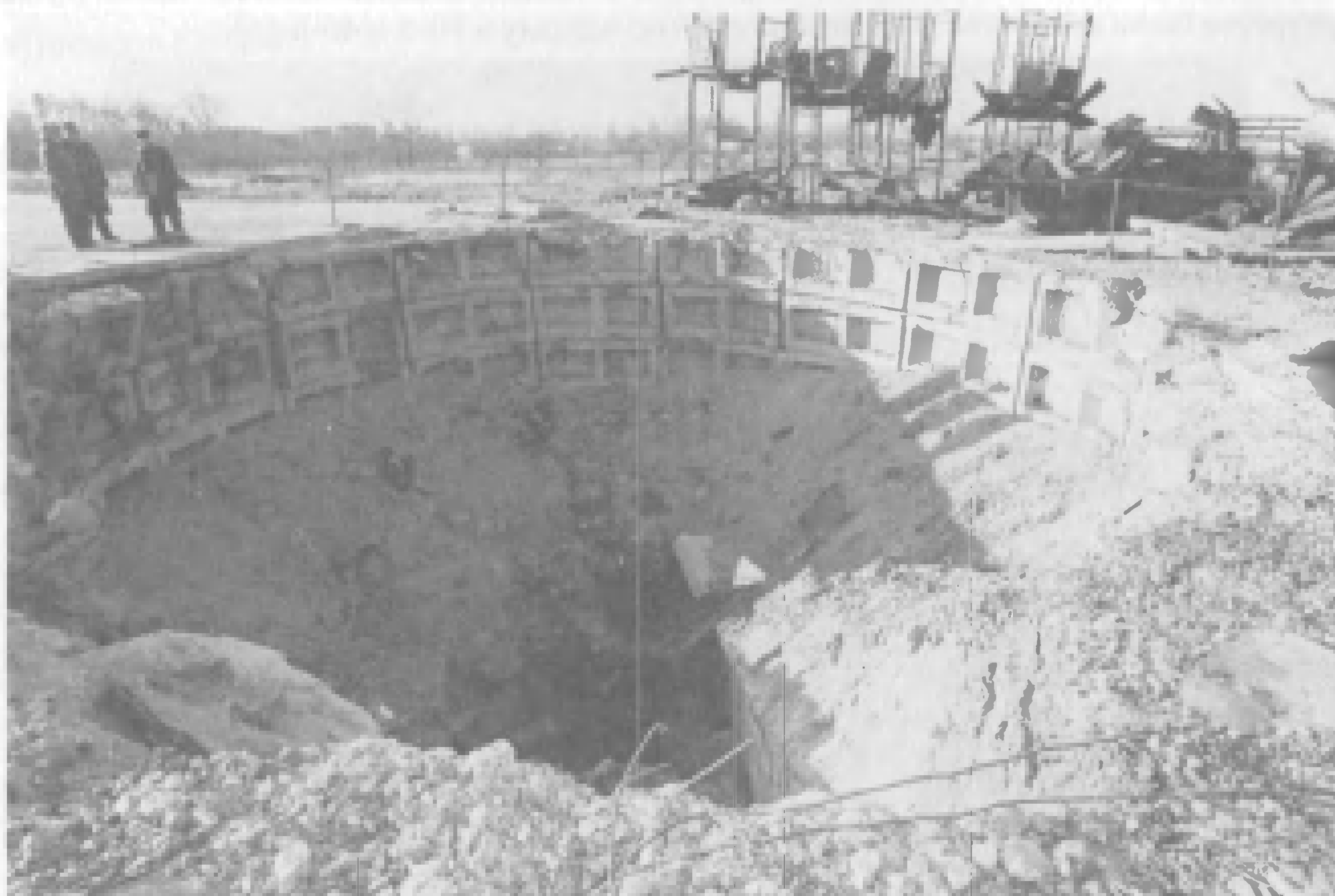
Уничтоженная методом взрыва ШПУ боевого ракетного комплекса с ракетами SS-19
