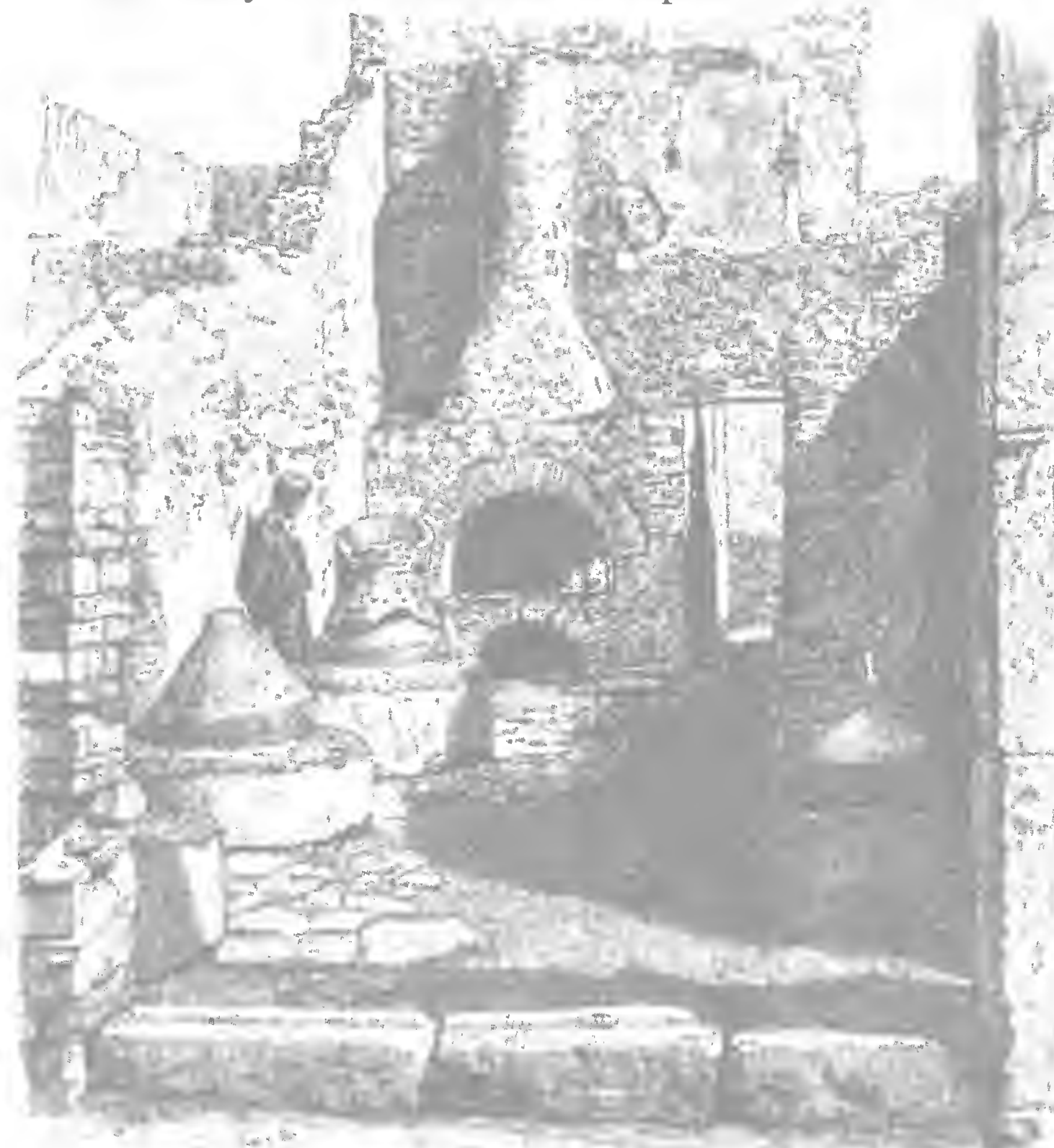
Римская печь с камином в пекарне, сохранившаяся в Помпеях. В нижней части печи находится отверстие для топлива; широкая полка перед печью предназначалась для лопатки, которой осуществлялась загрузка печи и выемка из нее; конические формы во внутреннем дворике являются мельницами для размолва пшеницы.
