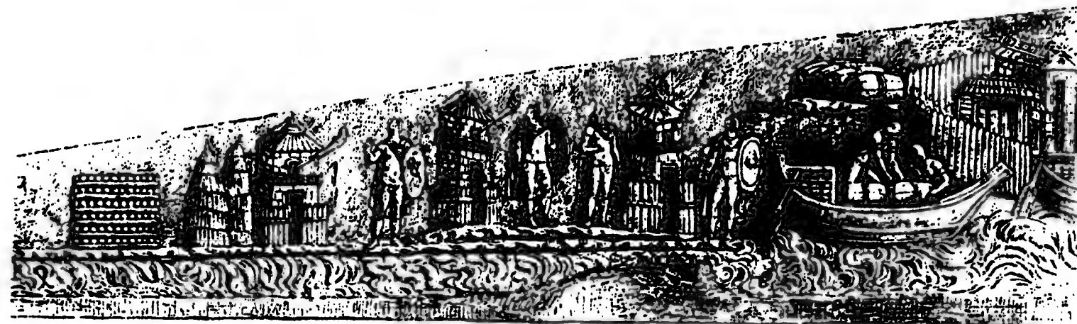
Римская телеграфная система, изображенная на колонне Траяна в Риме (построена приблизительно в 115 г. н. э.). Здесь изображены три сигнальные башни, из окон которых сигнальщики махали факелами. Слева, рядом с башней, находятся два стога сена и большая площадка, выложенная спиленными деревьями. В случае опасности сено можно было свалить на нее и поджечь в качестве сигнального огня — таков был римский эквивалент сигнала о бедствии.
