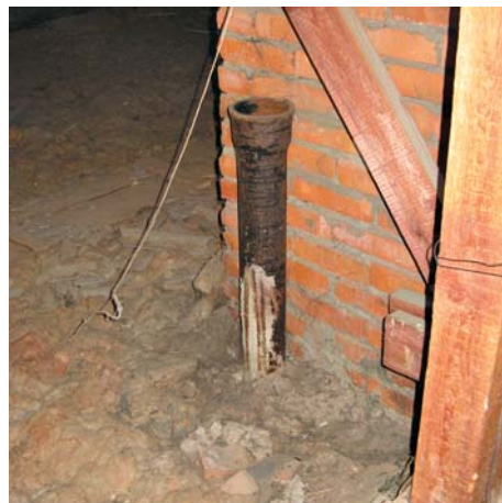
Рис. 75. Вывод канализационного стояка для вентилирования трубопровода на чердак дома
