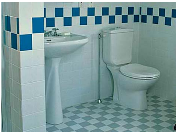
Рис. 101. Подключение бачка декоративной подводкой
