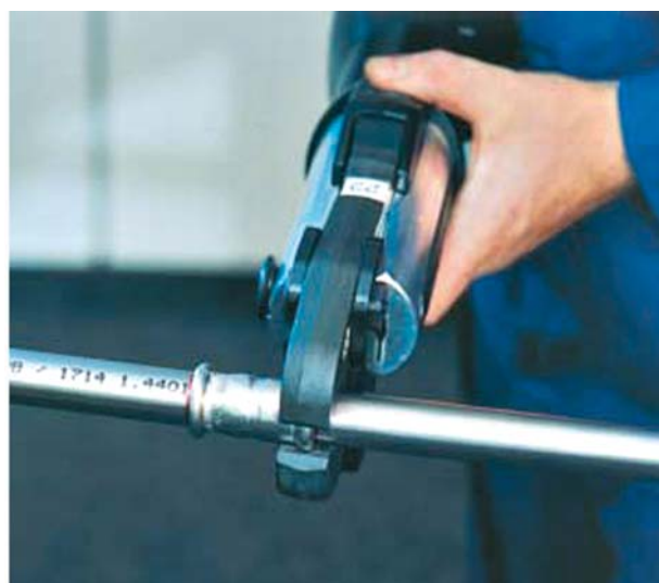
Рис. 45. Обжим стальных труб пресс-фитингами
