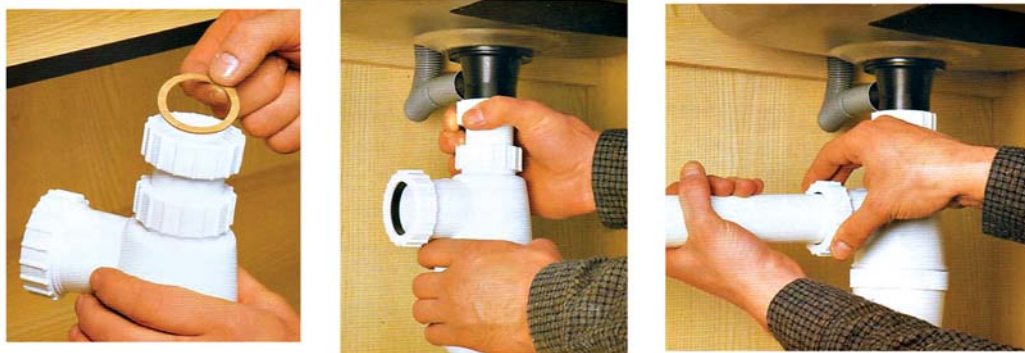
Рис. 114. Пример монтажа бутылочного сифона
