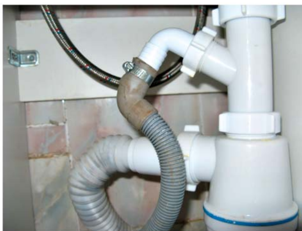
Рис. 119. Сифоны и детали к ним для подключения сливного шланга стиральной машины и пример подключения
