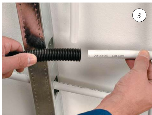
Надеть на трубу утепляющую гофру (необязательный пункт)
