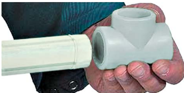
После нагревания соединить детали
