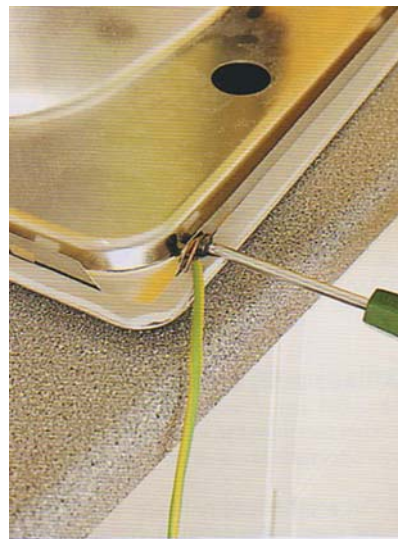
Рис. 108. Заземление металлических сантехприборов
