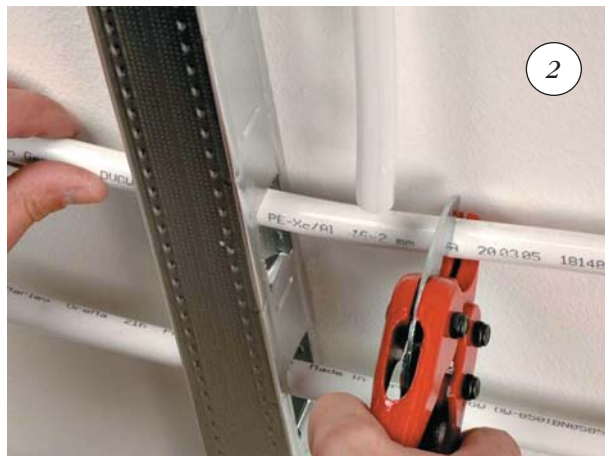
Разрезать трубу
