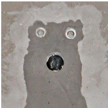
Рис. 88. Розетка подключения сантехприборов
