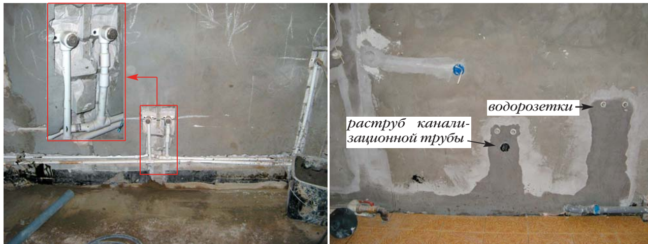
Рис. 63. Пример скрытой прокладки трубопровода из полипропиленовых труб с установкой водорозеток
