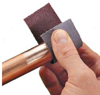
зачистить внешнюю поверхность трубы
