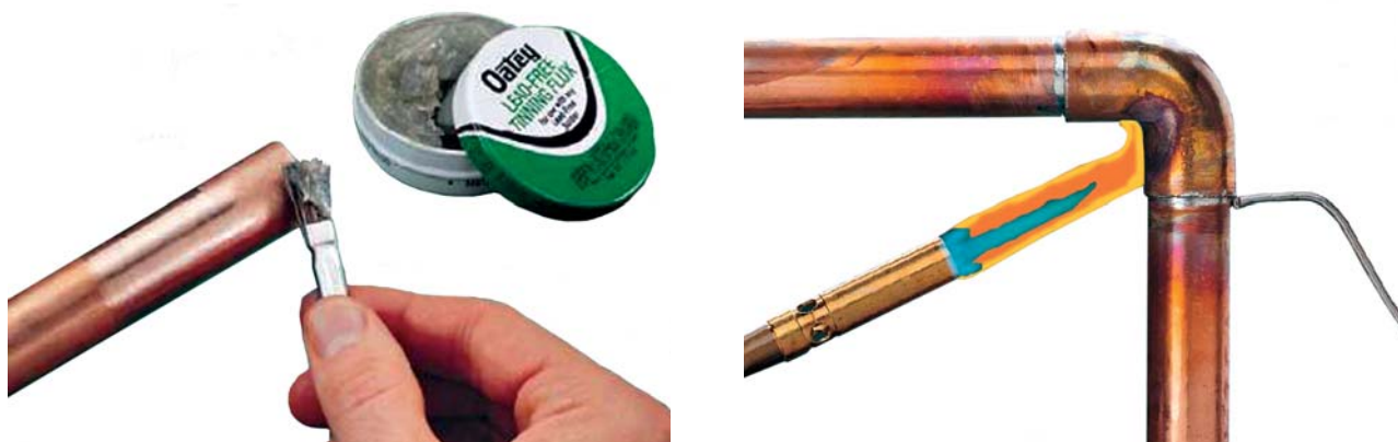
Рис. 38. Покрывание труб флюсом и пайка
