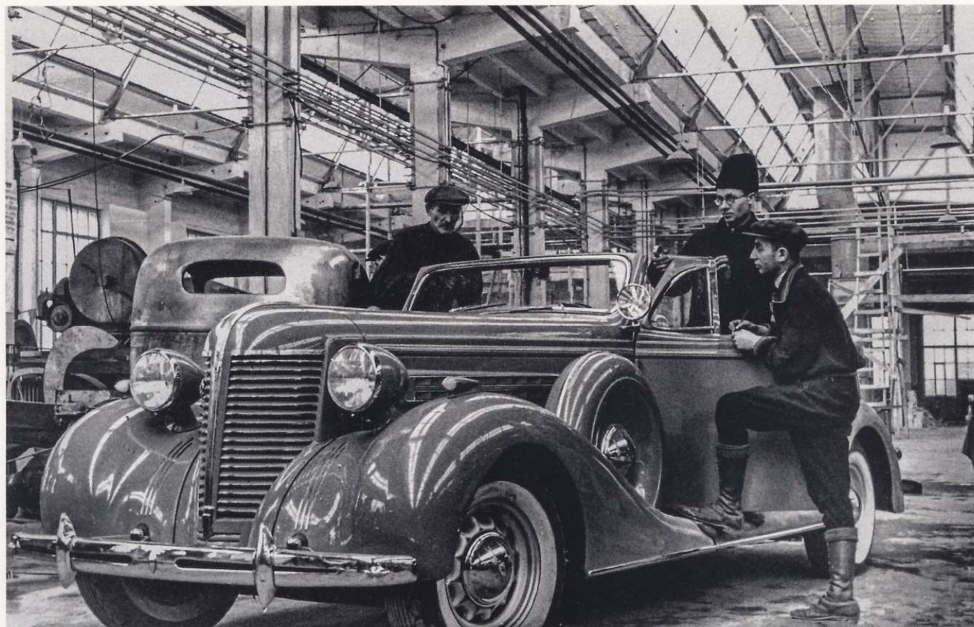
Модернизированный автомобиль ЗИС-102 в экспериментальном цехе завода на финальной стадии изготовления
