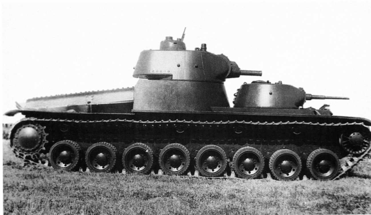
Танк Т-100 на полигонных испытаниях, вид с правого борта. Август 1939 года. Хорошо видна зенитная пулеметная установка на крыше большой башни (АСКМ).
