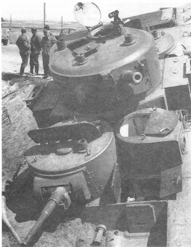
Тот же танк Т-35 выпуска 1938 года, брошенный экипажем из-за поломки. Июнь 1941 года. Пулеметные башни имеют дополнительную бронезащиту шаровой установки (АСКМ).
