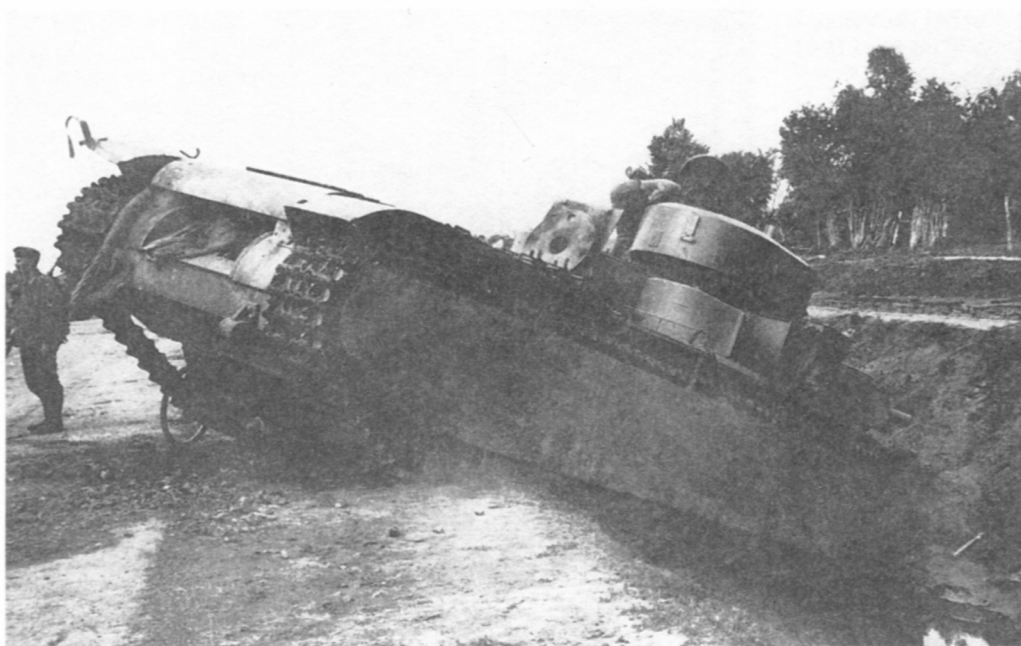
Тот же танк Т-35 выпуска 1938 года, брошенный экипажем из-за поломки. Июнь 1941 года. Пулеметные башни имеют дополнительную бронезащиту шаровой установки (АСКМ).
