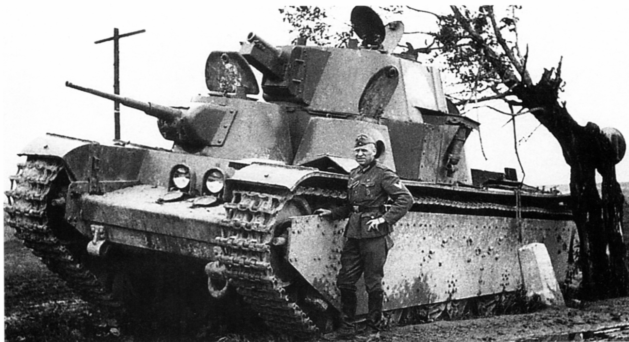
Брошенный Т-35 с коническими башнями. Июль 1941 года. Танк выпуска февраля — апреля 1939 года с прямой подбашенной коробкой (БА).
