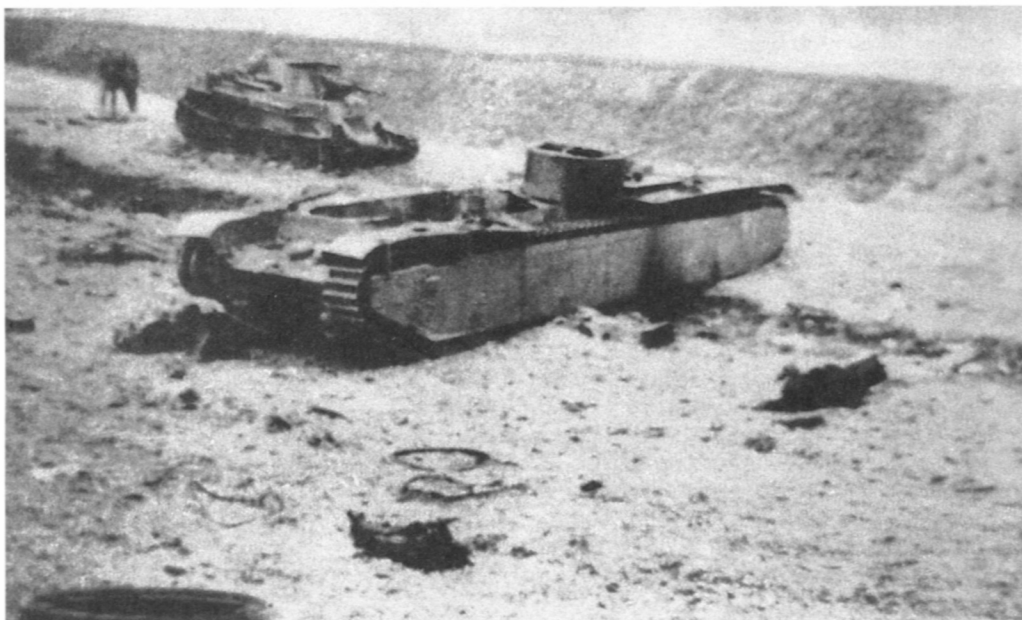
Оставленный в городке 34-й танковой дивизии Т-35 выпуска конца 1938 года с измененной формой бортовых экранов. К началу войны эта машина находилась в ремонте. На танке видны следы от попаданий нескольких снарядов — видимо, немцы тренировались в стрельбе по неподвижному гиганту. Садовая Вишня, июль 1941 года (БА).
