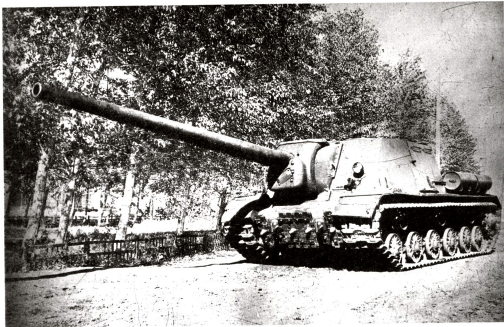
Опытная тяжелая САУ ИСУ-122-1 (объект 243) со 122-мм пушкой БЛ-9. Челябинск, июнь 1944 года.
