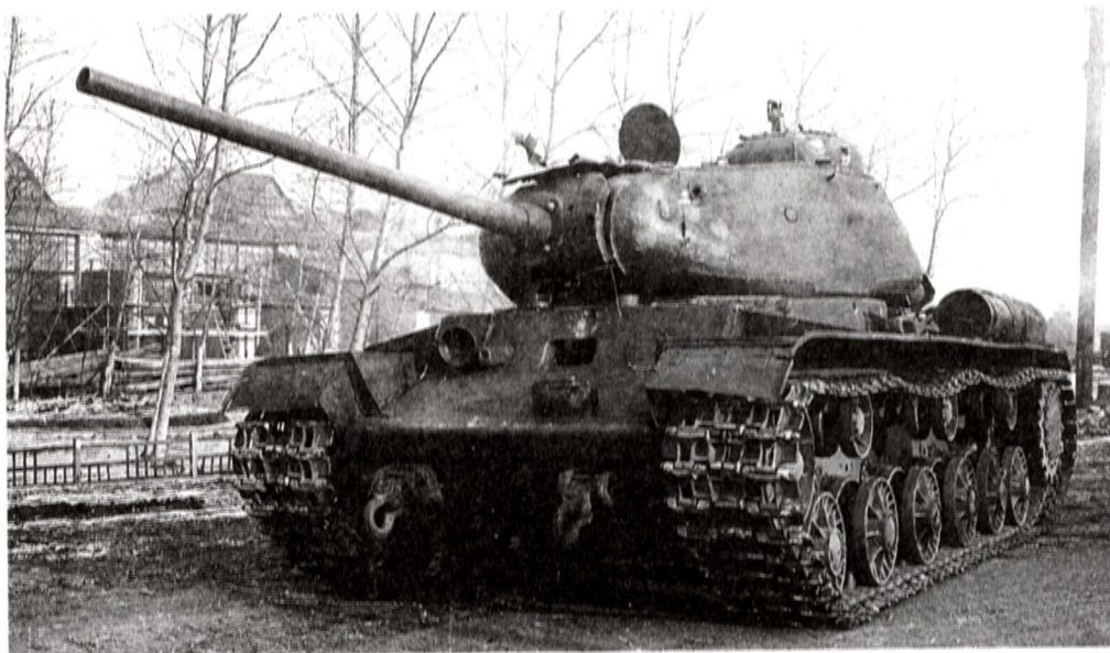
Опытный образец танка KV-85 (объект 239) после испытаний обстрелом. Челябинск, ноябрь 1943 года.
