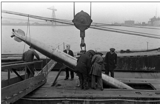
Погрузка торпед на «Вильк». Вверху – в поворотный ТА, внизу (три фото слева) – через торпедопогрузочный люк
