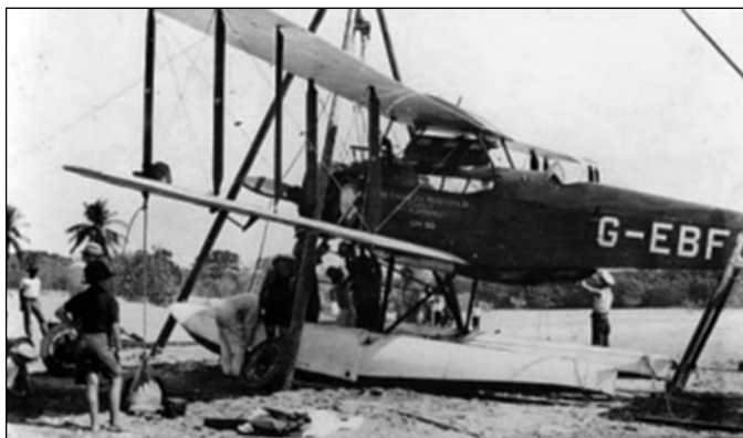
Установка поплавков на D.H.50J Алана Кобхэма
