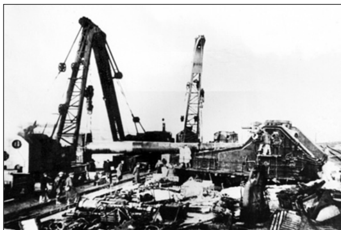
Установка ствола на лафет, 1940 г.
