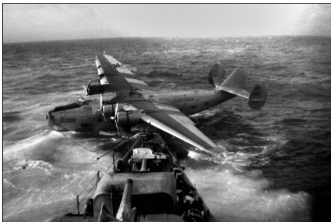
В-314 «Honolulu Clipper» (NC18601), снятый с ходового мостика плавбазы гидроавиации «Сан Пабло» (AVP30). В результате навала корабля на гидросамолет была повреждена правая плоскость крыла и потерян крайний правый двигатель №4, ноябрь 1945 г.
