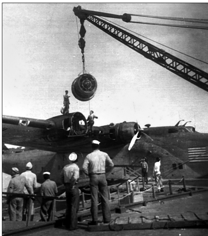
Замена двигателя на летающей лодке В-314, находящейся под управлением Авиационной транспортной службы ВМС США (NATS)
