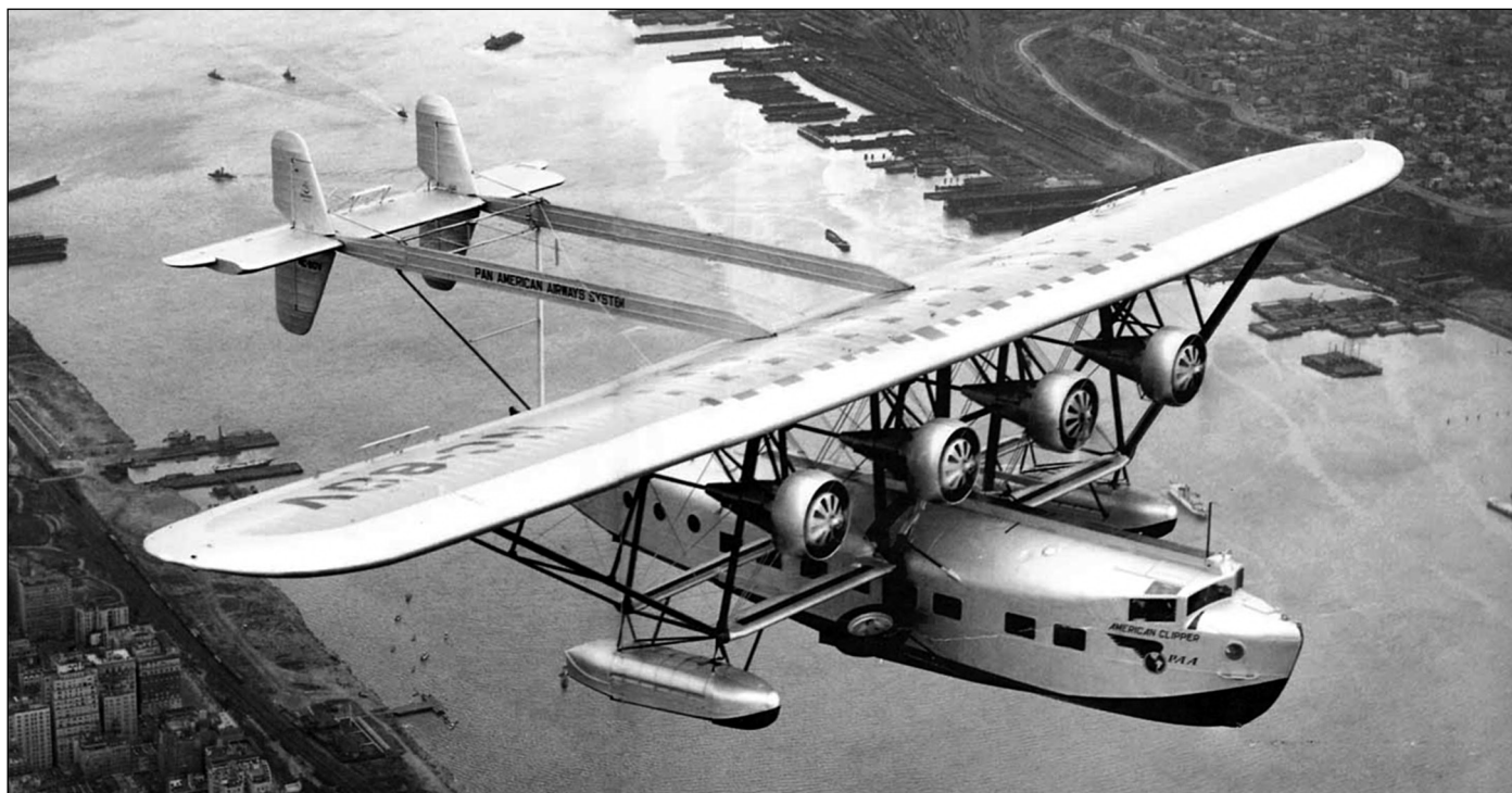
Летающая лодка S-40 «American Clipper» (NC80V) в полете. Самолет еще в первоначальном варианте амфибии. Из-за обилия подкрыльевых стоек и расчалок, Чарльз Линдберг называл его «летающим лесом»
