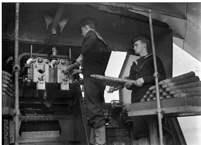
Процесс заряжания спаренной 57-мм установки лидера «Монтроз»
