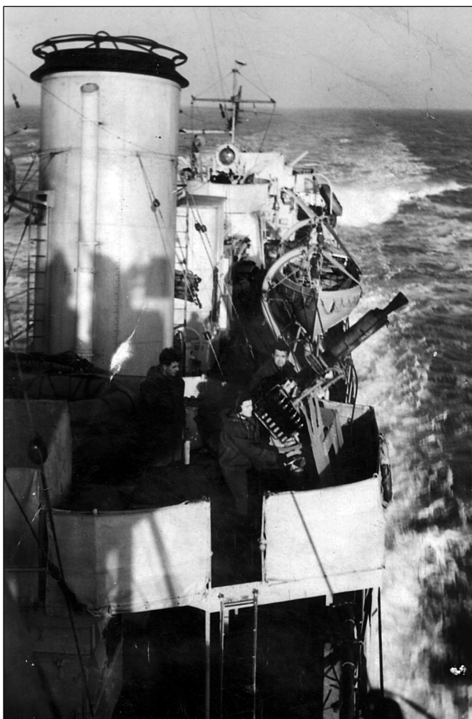
Лидер «Макей», вид с мостика в корму. Хорошо видна площадка 40-мм «пом-пома», оборудованная на месте, где ранее располагалось 120-мм орудие ГК
