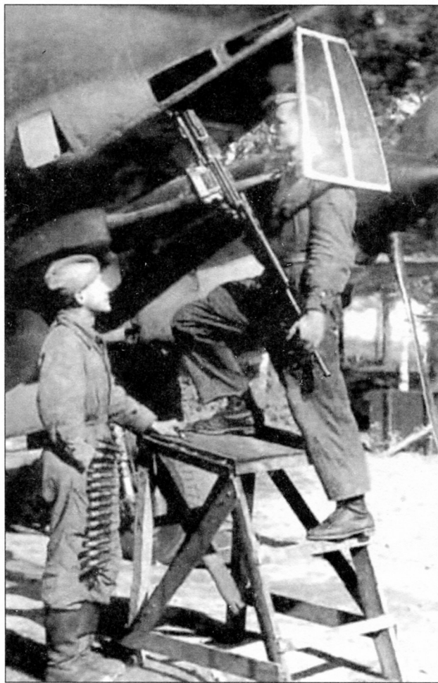
Специалисты из группы вооружения устанавливают крупнокалиберный пулемет БК после чистки в носовую огневую точку разведчика Пе-2
