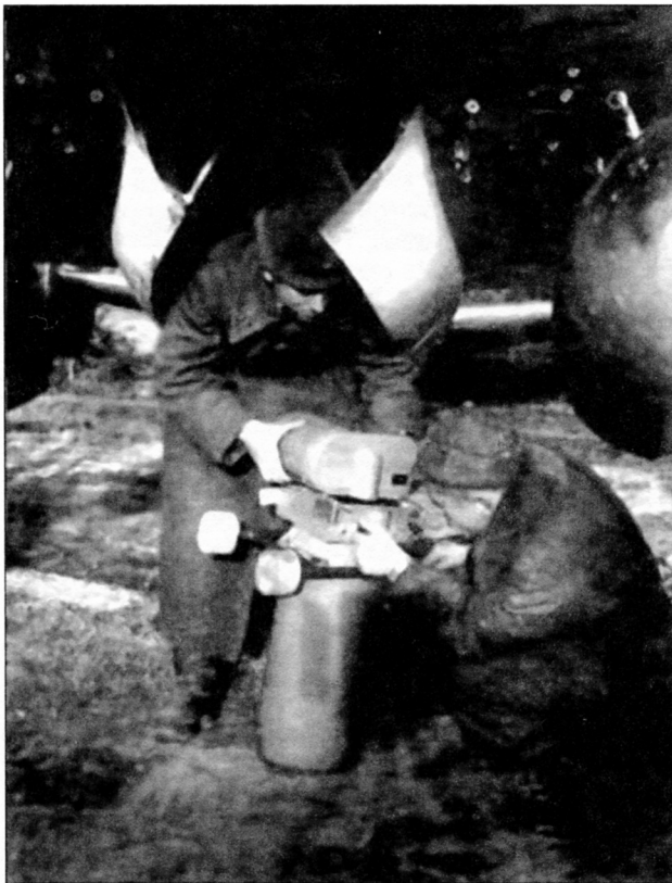
Механики по фотооборудованию готовят камеру АФА-1 к установке в отсек полезной нагрузки. Створки люка выполнены выпуклыми для уменьшения влияния воздушного потока на объектив камеры
