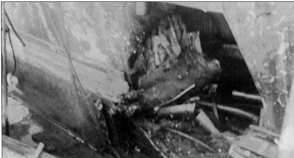
«Пересвет». Одна из пробоин в борту, полученная в бою 28 июля 1904 года
