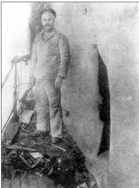
Пробоина на эскадренном броненосце «Победа», полученная в бою с японскими кораблями
