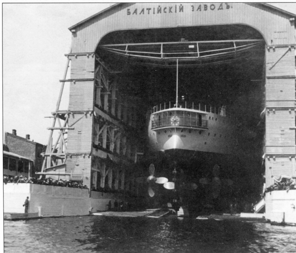
Корпус броненосца «Победа» на стапеле крытого деревянного эллинга перед спуском на воду
