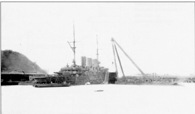
Три снимка, запечатлевшие этапы подводки кессона к пробоине эскадренного броненосца «Победа»
