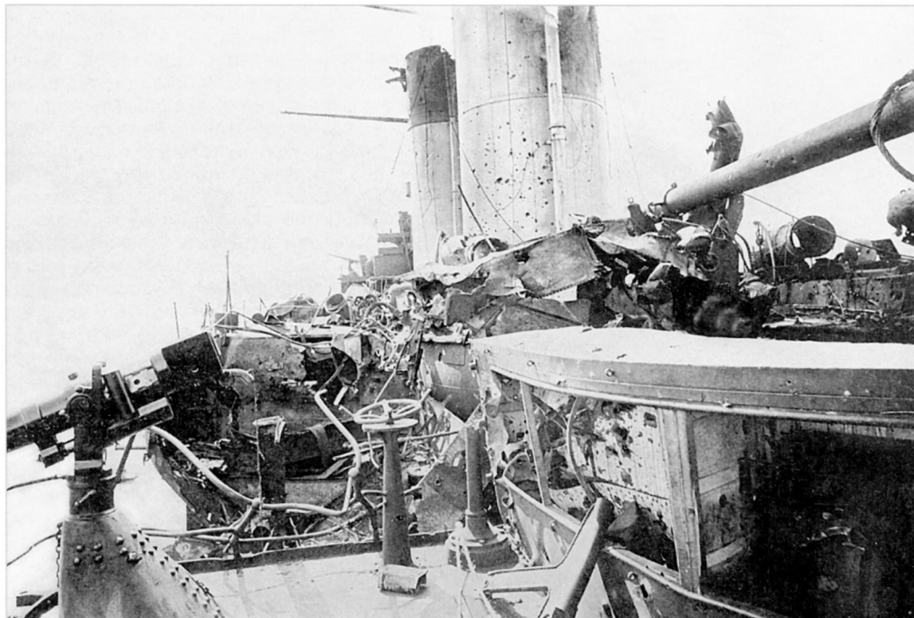
«Орел». Повреждения на рострах между кормовым мостиком и второй дымовой трубой
