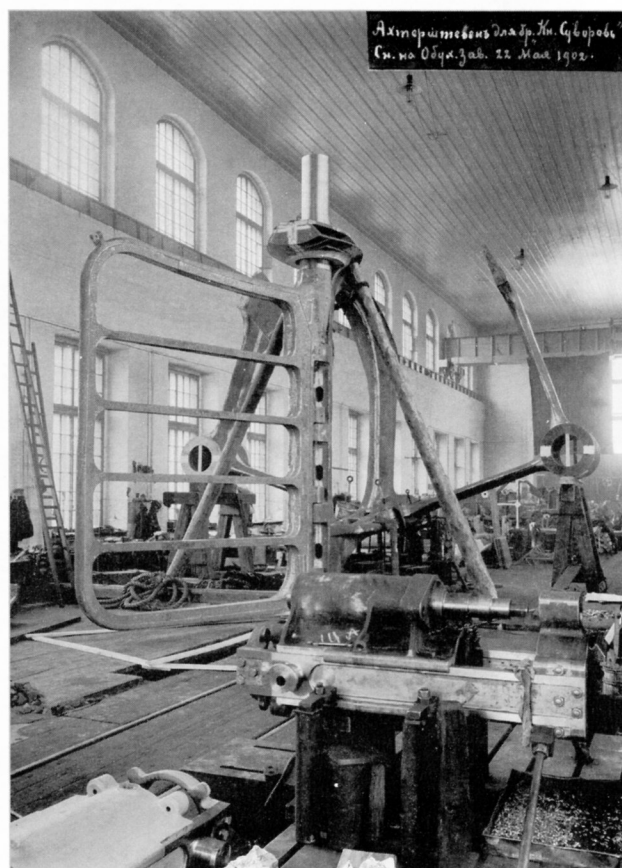
Отлитые из стали на Обуховском заво- де для броненосца «Князь Суворов» форштевень (слева) и кронштейны греб- ных валов и рулевая рама в мастерской предприятия. 22 мая 1902 года
