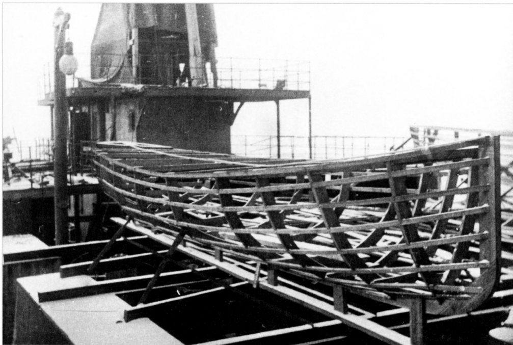
«Бородино». Макет шлюпки в натуральную величину без обшивки, с помощью которого производилась разметка по установке кильблоков для гребных судов. 19 января 1904 года. РГАВМФ. Ф. 417. Оп. 1. Д. 2836
