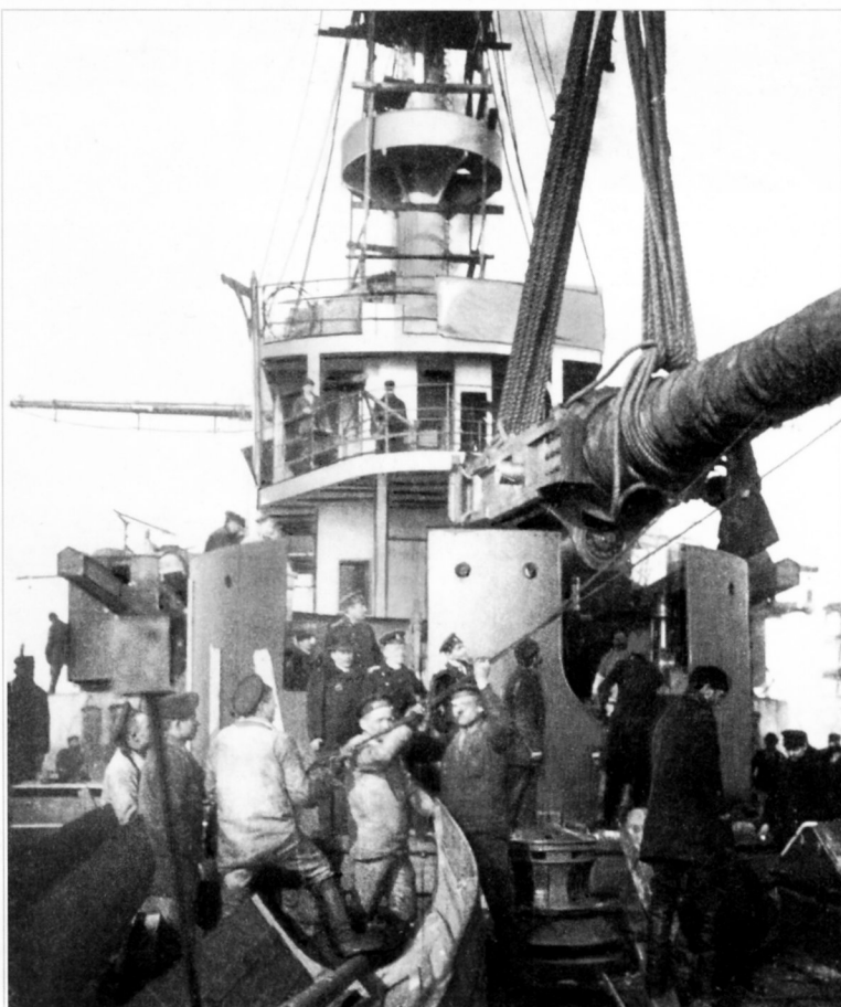
«Бородино». Работы по монтажу левого 305-мм орудийного ствола кормовой башенной установки. 14 апреля 1904 года. Из фондов РГАВМФ
