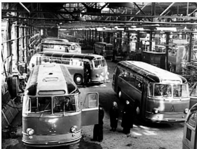
🚩 Сборка автобусов ЛАЗ-695
