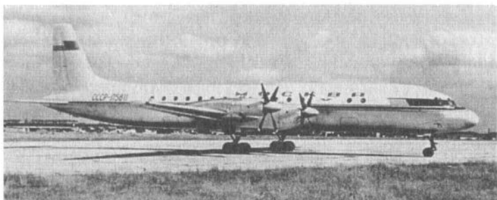
Первый прототип Ил-18 «Москва» с турбовинтовыми двигателями
