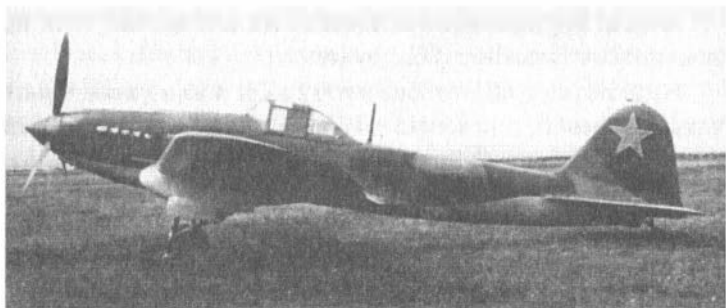
ЦКБ-57 с мотором АМ-38 — второй одноместный прототип штурмовика Ил-2
