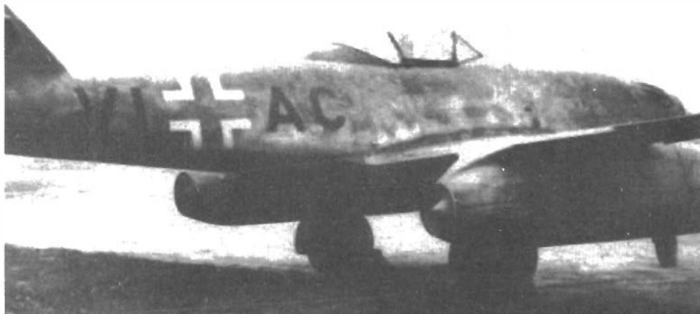
Тестовый Me.262V8 с установленными ускорителями RI 502
